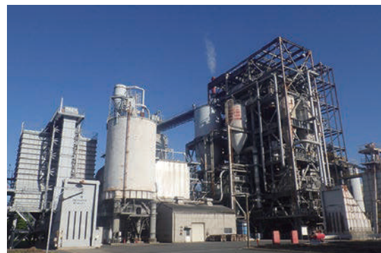
東レ（株）東海工場の汚泥燃料混焼設備
