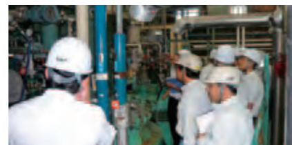
防災査察チームによる現場査察(曾田香料(株)野田工場)
