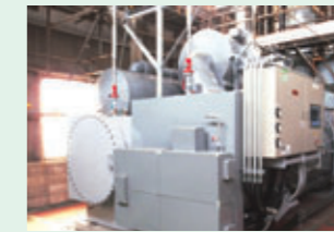
東レ(株)東海工場に設置した高効率型冷凍機
