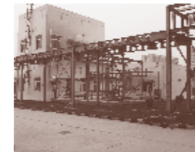
藍星東麗膜科技(北京)社の新設MBR処理設備
