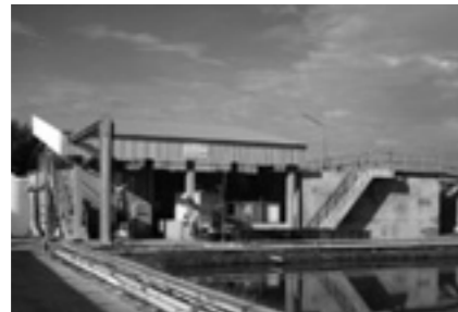
ラッキーテックス 第3工場の 排水処理設備
