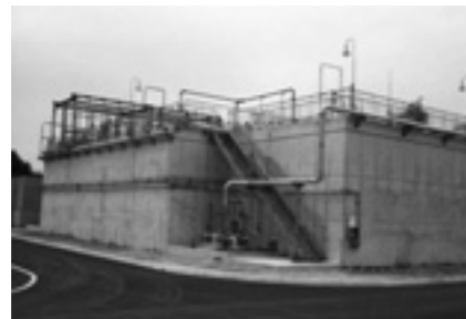
東海工場の 新設MBR処理設備
