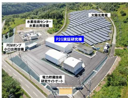
P2Gシステム技術開発 山梨県米倉山電力貯蔵技術研究サイト
