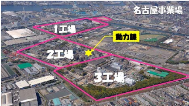
用役設備は第1～3工場に点在する
