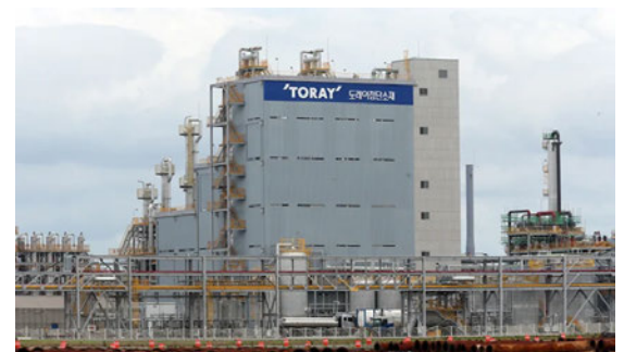
PPS樹脂を生産する群山工場全景（Toray Advanced Materials Korea Inc.）
