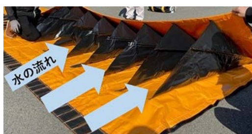
(例) ウォーターゲートの設置
