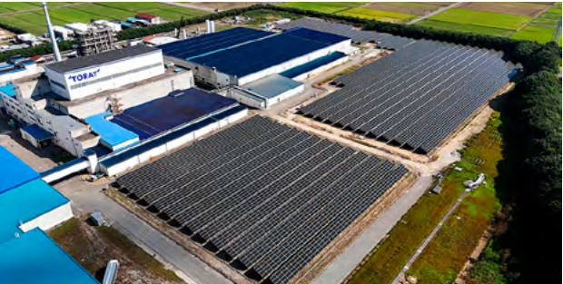
石川工場の太陽光発電設備
