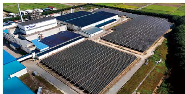
石川工場の太陽光発電設備
