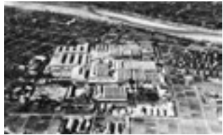
愛知工場全景(1952年)
