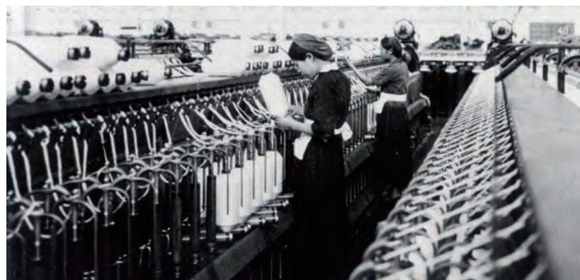
瀬田工場の粗糸機 Seta Plant roving frame
