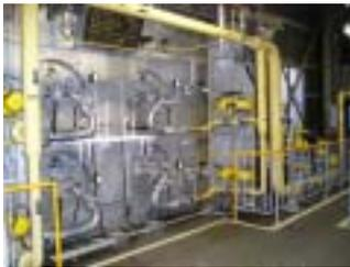
(改造後のボイラー) | 自家発電ボイラーを <b>重油</b> 燃焼<br>から <b>都市ガス</b> に転換<br>(稼働開始:2007年7月)<br>
