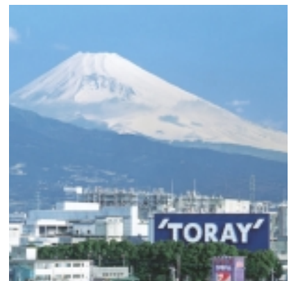
高性能薄膜フィルムの設備を新設中の三島工場
