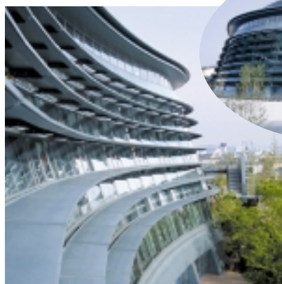
CFRPを使用した京都西京極スポーツセンターの庇(2002年6月竣工)
