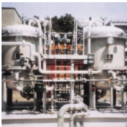
ポリアクリロニトリル中空糸膜モジュールを使用した浄水装置
