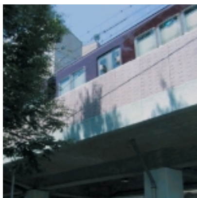
CFRPを使用した鉄道高架用の防音壁施工例
