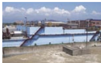
排水処理設備 (タルテックス(珠海))
