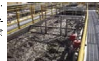
東レのMBR用浸漬膜モジュールが使われている アル・アインにある下水リサイクルプラント (アラブ首長国連邦)
