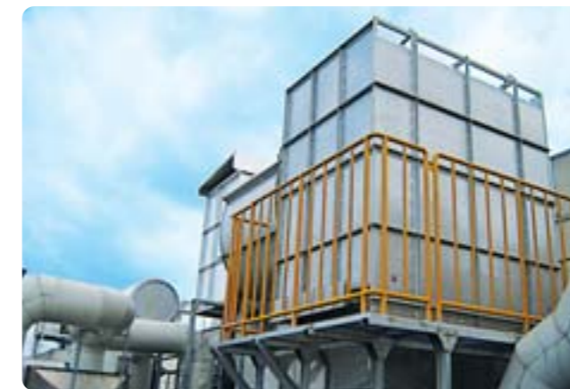
東レフィルム加工に設置した有機系排ガスの触媒燃焼装置
