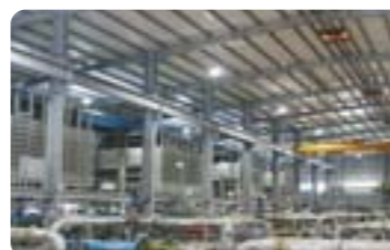
東レの逆浸透膜を使用したシンガポールの海水淡水化プラント 写真提供:Hyflux社
