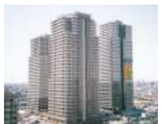
東京都南千住E街区建設事業に関するアセスメントを行いました
